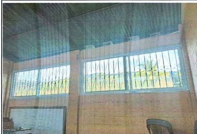
Foto 1: Finalización de la Instalación de Ventanales en el S-5
