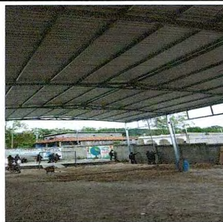
Foto 4: Finalización de cubierta lámina
