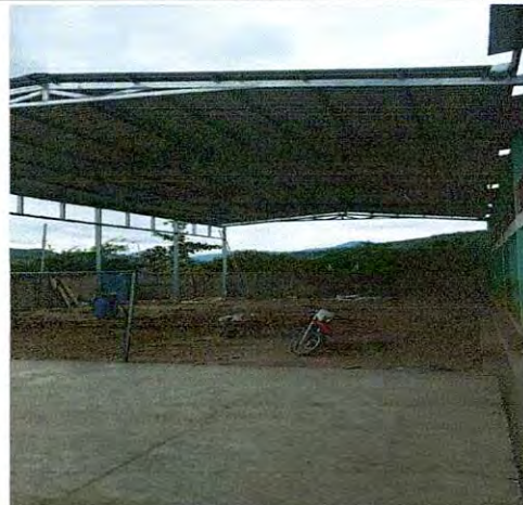
Foto 2: Puesta de estructura y cubierta de lámina
