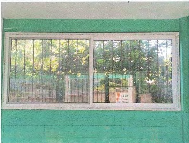
Foto1: Finalización e instalacion de ventanales en el S-4
