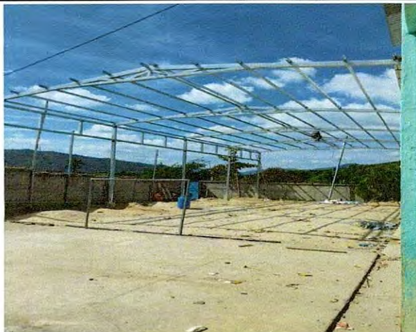
Foto 1: Posterior a las bases y vigas de metal
