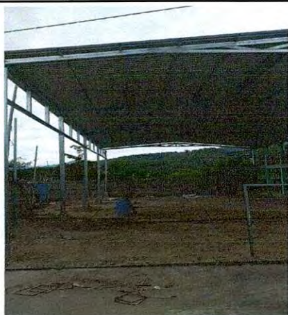
Foto 3: Perfil de cubierta de Lámina
